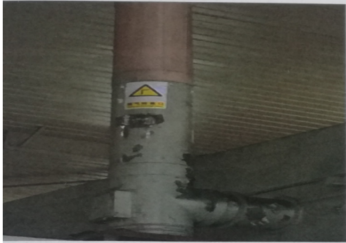
天然气燃烧废气排气筒
